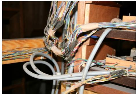
Die Orgelbaufirma Späth hat sich außerdem sehr mit der Sicherheit der Elektrik im Orgelbau auseinandergesetzt und kann daher die fachgerechte Erneuerung der Verkabelung und aller elektrischen Bauteile gewährleisten. Zusätzlich wird die seit Jahrzehnten defekte Schwellersteuerung überarbeitet und ein neuer Schwellermotor eingebaut.
